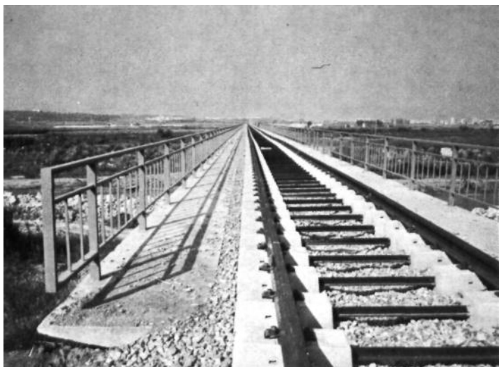
Puente sobre el río Guadalhorce, con vía en montaje
