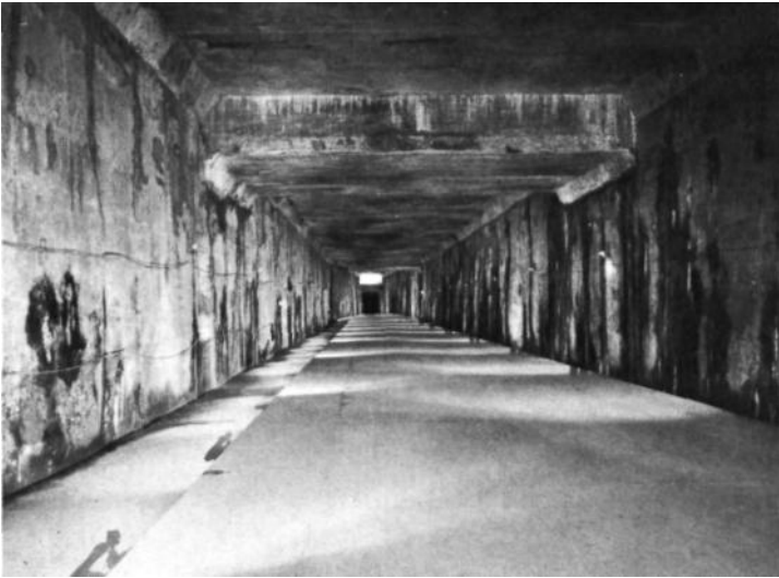
Estación de Fuengirola en construcción
